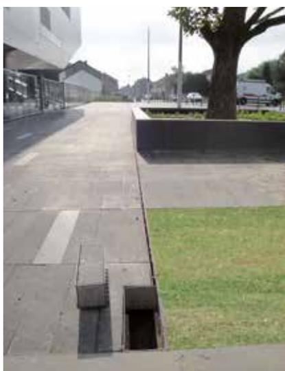
Le bac à sable, ainsi que le piège à sable sont accessibles facilement, en enlevant la grille du caniveau.
