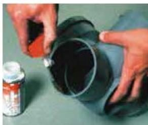
1 - Coller la culotte sur le tube de l'étage inférieur.
