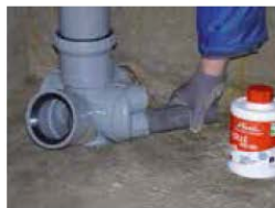
6 - Connecter les petits collecteurs dans le module ainsi que la culotte dans le tube de l'étage inférieur.
