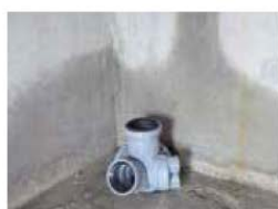
1 - Positionner à blanc la culotte et son module pour choisir sur quelle emboîture positionner le module.
