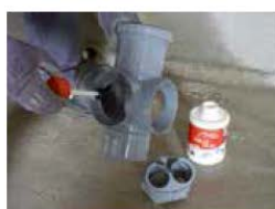
2 - Dépolir, dégraisser et encoller l'intérieur et l'extérieur de l'emboîture choisie sur la culotte.
