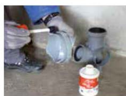
3 - Dépolir, dégraisser et encoller l'emboîture du module.
