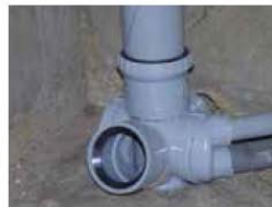
7 - Pour les collecteurs Ø 40mm, insérer une réduction incorporée IJ entre l'emboîture femelle Ø50 du module et le tube, ou un tampon souple désoperculable JA,J4. Si vous ne connectez qu'un collecteur, condamner l'emboîture restante avec un tampon PJ.
