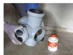
4 - Enfoncer sans attendre le module à fond d'emboîture. L'angle pour la pente est réglable de 1 à 2,5°.
