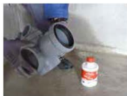
5 - Dépolir, dégraisser et encoller de la même façon les 2 bouchons sur les emboîtures restant disponibles.
