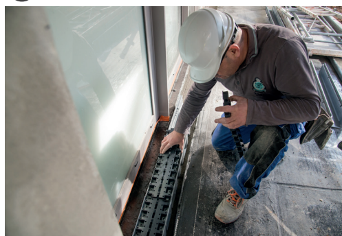
3.1 Mettre les grilles en place sur les corps de caniveaux. Présenter la grille côté recto (« N » vers le haut) en respectant l'indexation*.
