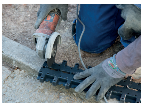
Dans le cas d'un caniveau recoupé, veiller à laisser, au minimum, 3 mm d'espace libre entre l'extrémité de la grille et le fond/naissance.
