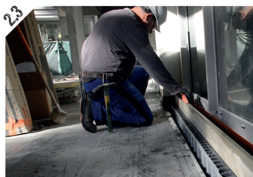
2.3 Afin de conserver le bon écartement et l'espace de dilatation, prévoir, lors du scellement du corps de caniveau, une entretoise de 129 mm de large ou installer une grille avec cale pour maintenir le jeu d'assemblage.
