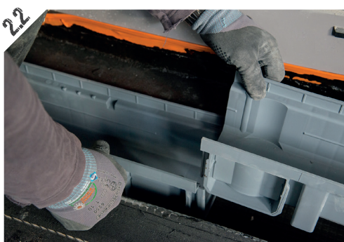
2.2 Assembler les corps de caniveaux sur la semelle béton en tenant compte du raccordement Mâle/Femelle.
