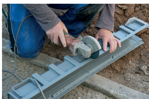
Dans le cas d'un caniveau recoupé, veiller à laisser, au minimum, 3 mm d'espace libre entre l'extrémité de la grille et le fond/naissance.
