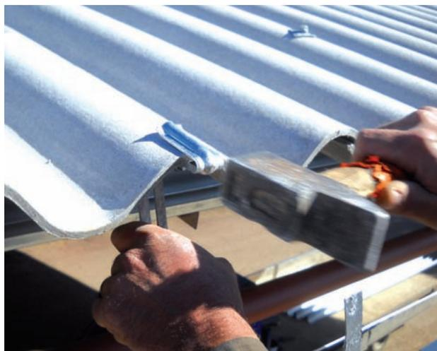
Particulièrement résistants à la corrosion (acier galvanisé à chaud après fabrication), ces nouveaux crochets ont passé avec brio le test du brouillard salin, y compris avec l'utilisation d'une vis autoperceuse (diamètre de 4,8 mm) en zone de neige ! En effet, **Nicoll** complète sa gamme avec une version conforme au DTU en vigueur, pour chacune des deux applications (toitures fibre-ciment ou bac acier).
