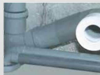
4 - Retirer à l'aide d'une pince les **opercules du tampon de réduction universel** utiles. Connecter les collecteurs sanitaires et le WC.
