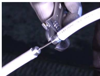
Visser l'autre embout dans le tube neuf.
