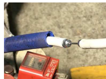
L'ancien tube est désormais remplacé par un neuf.
