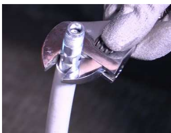
Visser le 1 er embout dans le tube endommagé.
