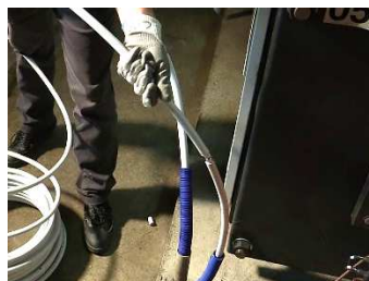
Pousser sur le nouveau tube, tout en tirant sur l'ancien. (Le tube endommagé est utilisé comme tire-fil pour guider le nouveau).
